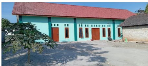
Gambar 1. Gedung MWCNU Desa Pohijo sebagai tempat pelaksanaan program bimbingan belajar gratis.
